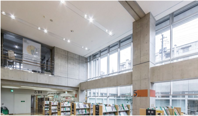
天井下地材：ダイケンハイブリッド天井 天井材：ロックウール化粧吸音板 ダイロートン トラバーチン12mm
