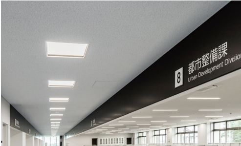
天井材：ロックウール化粧吸音板 ダイロートン スーパーワイド直張 耐震天井工法：ダイケンハイブリッド天井
