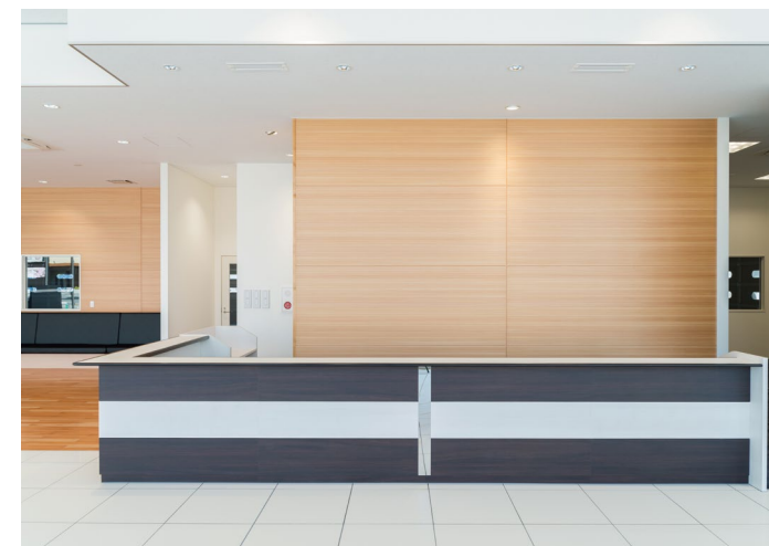
床材: コミュニケーションタフ DW (地域産材対応突板)〈紀州杉〉 壁材: 紀州杉突板張り ダイライト不燃壁材
