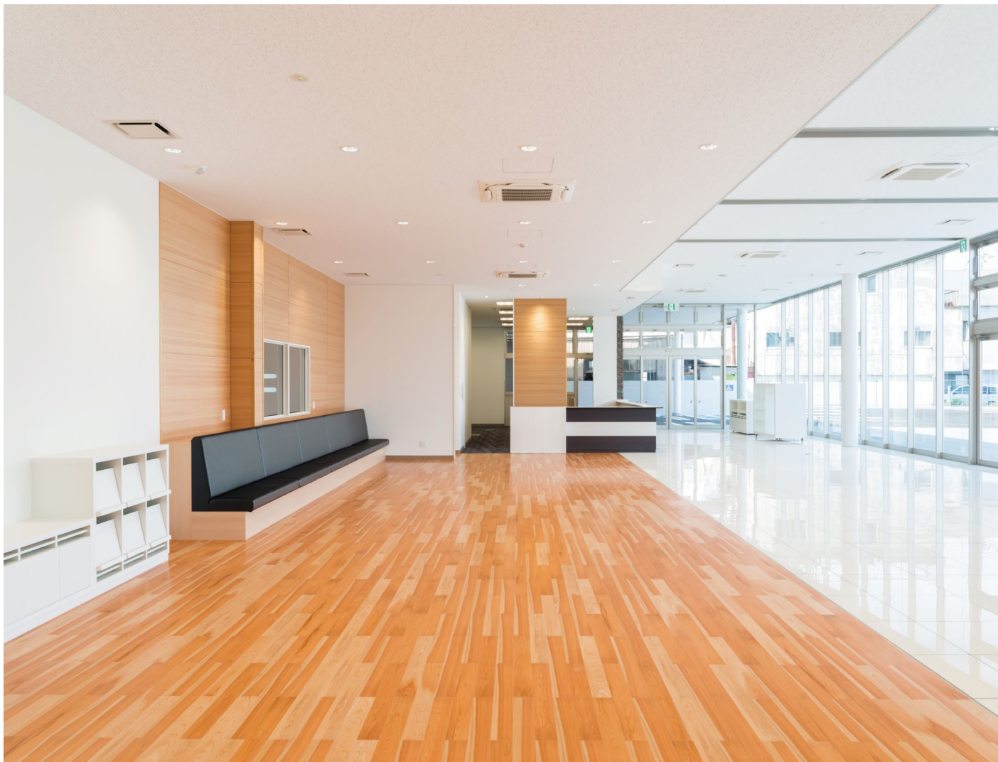
床材: コミュニケーションタフ DW (地域産材対応突板)〈紀州杉〉 壁材: 紀州杉突板張り ダイライト不燃壁材
