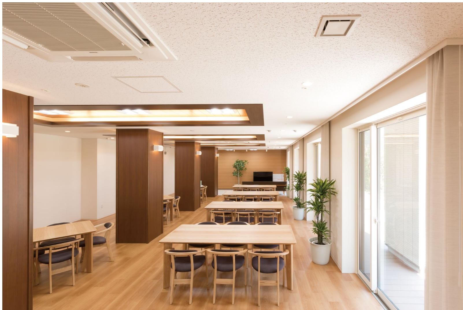
天井材：ロックウール化粧吸音板 ダイロートン トラバーチン9mm（サイズ特注）
