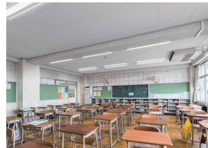
天井材:ロックウール化粧吸音板 ダイロートン 直張ベベル600 耐震天井工法:ダイケンハイブリッド天井
