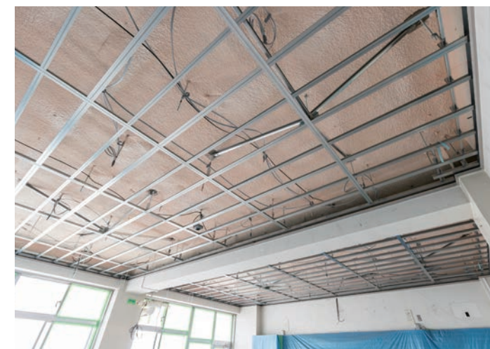
耐震天井工法:ダイケンハイブリッド天井
