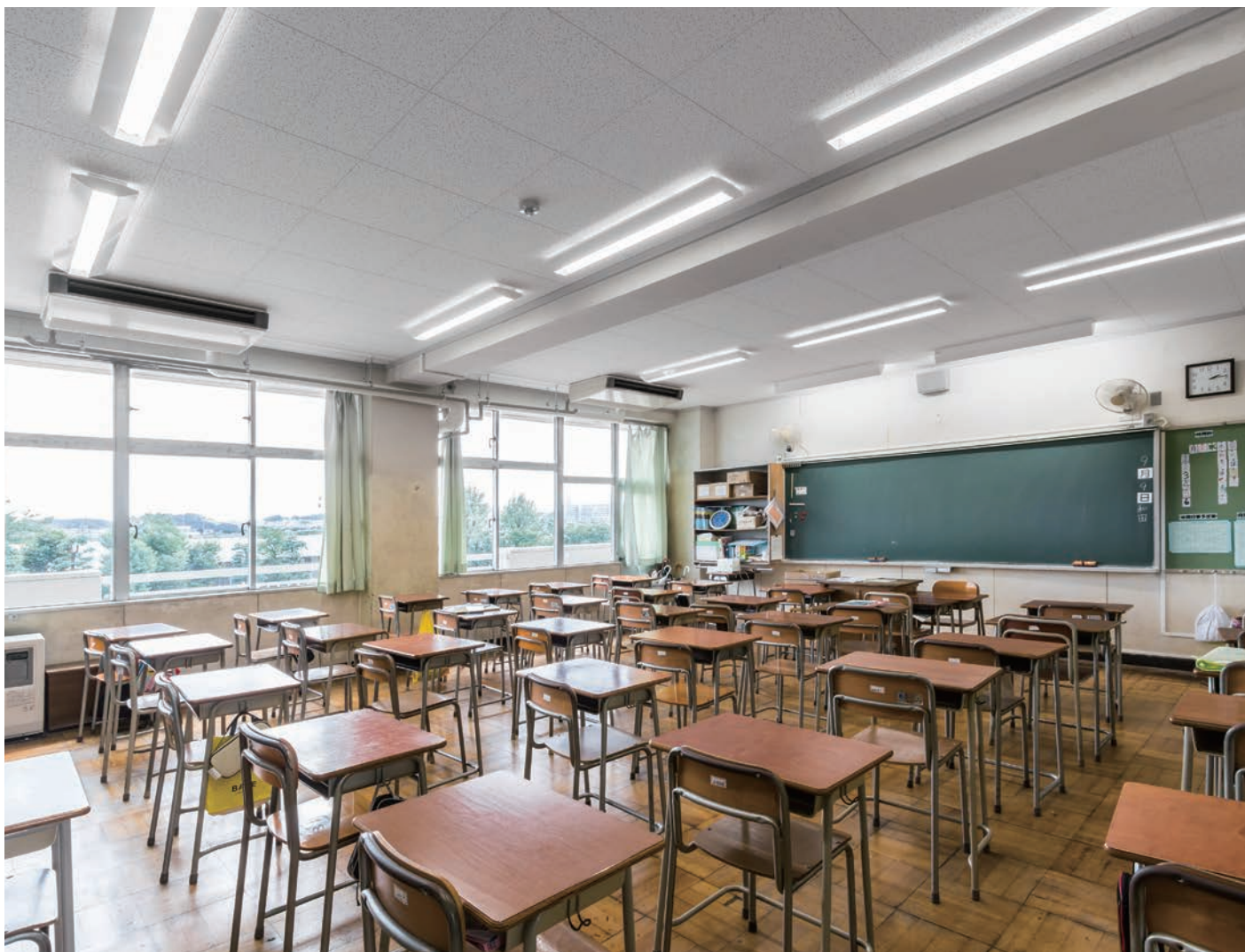
天井材:ロックウール化粧吸音板 ダイロートン 直張ベベル600 耐震天井工法:ダイケンハイブリッド天井
