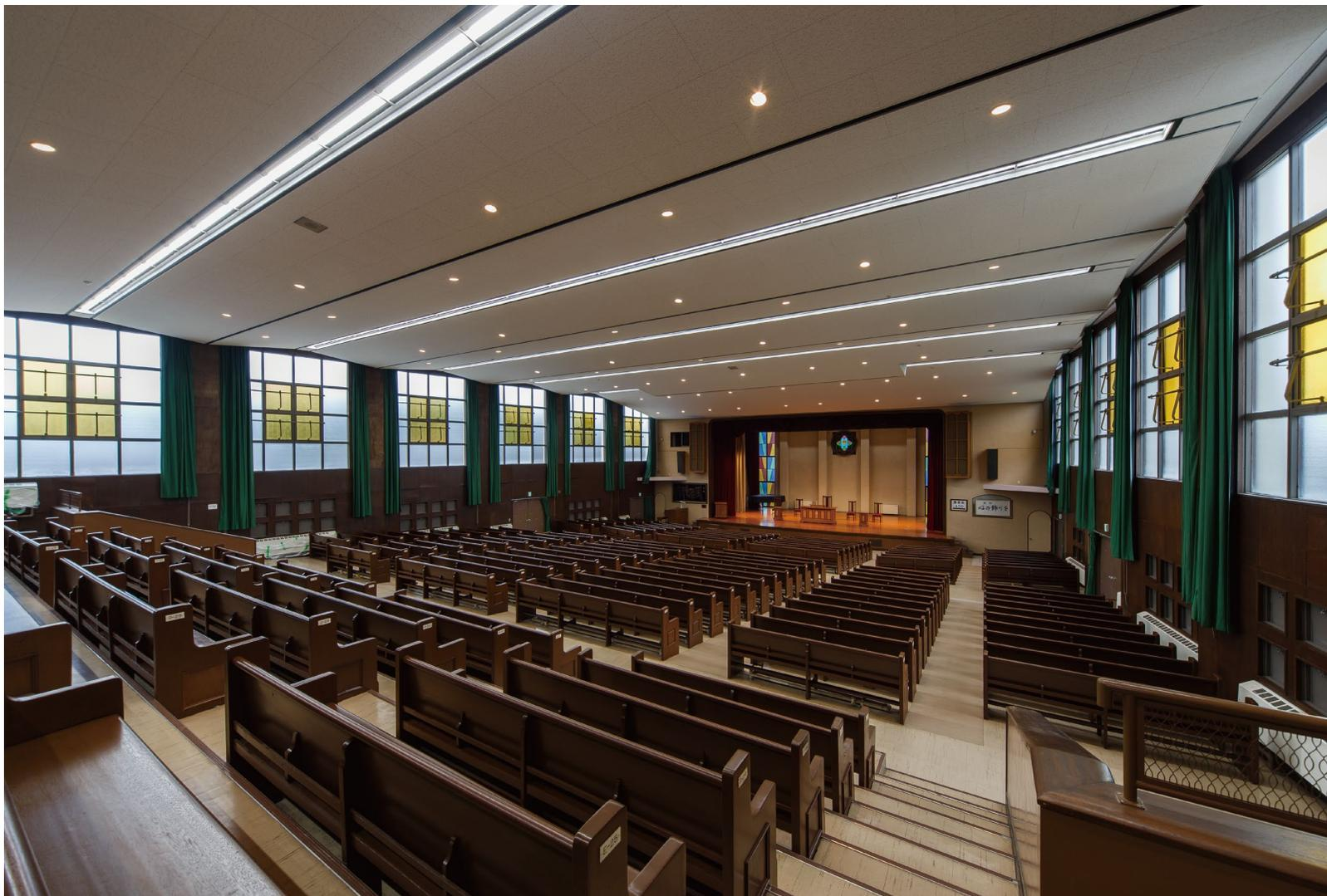
天井材：ロックウール化粧吸音板 ダイロートン スーパーワイド直張〈トラバーチン〉
