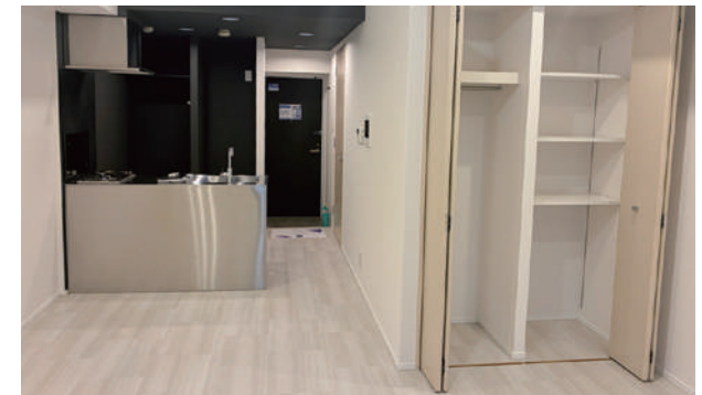
リノベーション工事事例
