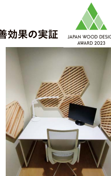
木製の音響調整パネルを設置した個室
