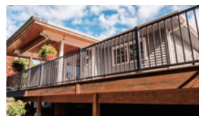
ウッドデッキに施工した防腐LVL
