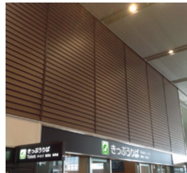
▲北陸新幹線富山駅に採用された富山県産スギ不燃パネル
