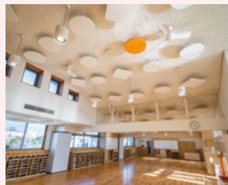
▲天井用吸音パネル「KIN TONE (キントーン)」の施工例
