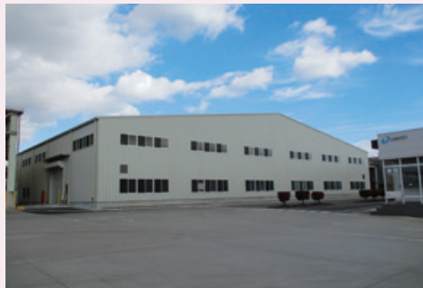
▲新設備導入のため増築された三重工場 久居製造課 第2工場
