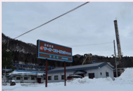
▲無垢・厚単板フローリングを製造する(株)テーオーフローリング夕張工場
