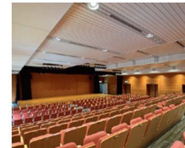
↑ 耐震天井工法「ダイケンハイブリッド天井」(中央大学 多摩キャンパス)
