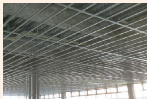
▲耐震対策が施された「ダイケンハイブリッド天井」の施工例
