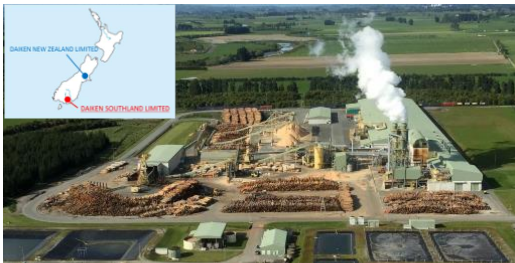
ダイケンサウスランド社 工場全景
