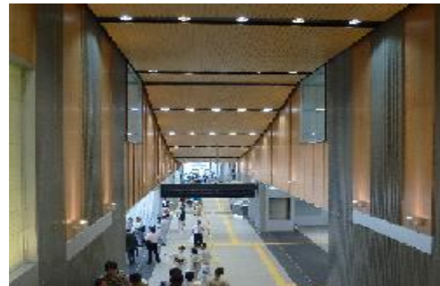
＜ダイライト＋スギ突板による不燃壁材＞ 【北陸新幹線 黒部宇奈月温泉駅】
