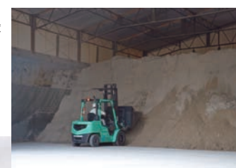
「ダイライト」の原料であるシラス(火山灰)の搬入倉庫
