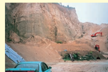
九州のシラス採掘現場
