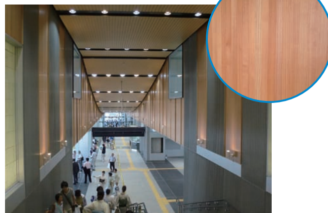
北陸新幹線黒部宇奈月温泉駅の壁・天井に採用された不燃パネル
