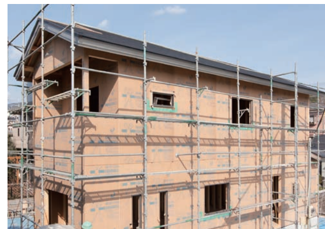
耐力面材「ダイライトMS」施工例
