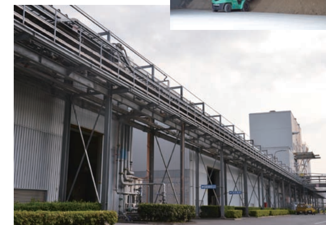
「ダイライト」を生産する岡山工場
