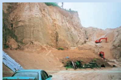
九州のシラス採掘現場
