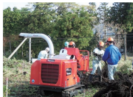
チップパー機による残材処理
