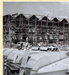
●岡山工場の建設風景
