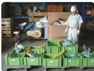
LNG用バーナーの取り替え作業
