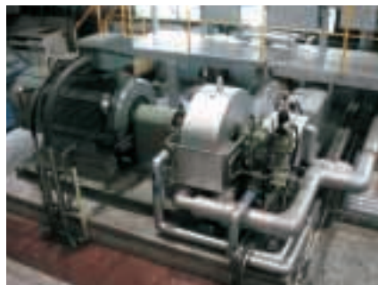
蒸気タービン発電機の導入
