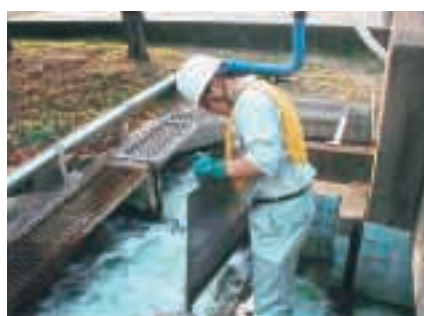
緊急時の対応訓練（排水処理施設） 排水への危険物流失回収訓練 （ゲート切り替え操作）
