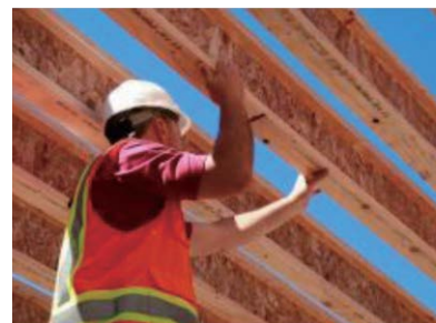
I-Joistを施工する様子
