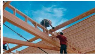
住宅の根太に施工するI-Joist
